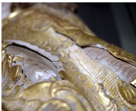
Imágenes 4 a 9. Detalles del estado inicial.
