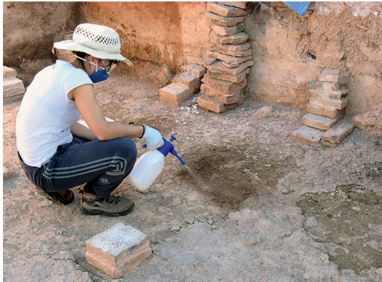
Consolidación del suelo del caldarium con silicato de etilo.
