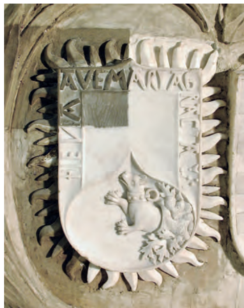
Fig. 40. Testigo de suciedad de escudo de alabastro.
