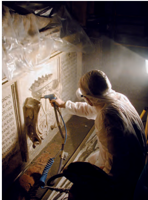
Fig. 34. Limpieza superficial de la lápida con proyección de microabrasivo a baja presión.
