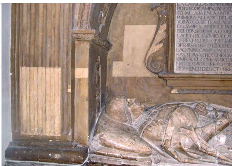
Fig. 27. Limpieza superficial y eliminación de enmascarado del monumento.
