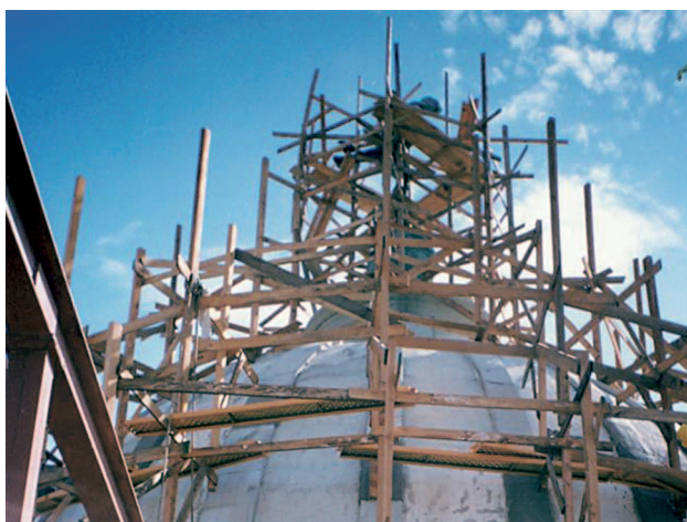
Fig. 4. Vía de acceso a la cúpula del edificio.
