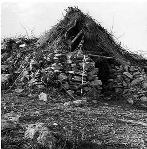
Construcciones pastoriles de Alhambra. e) Chozo-bombo de agricultor, levantado con piedras y cubierta vegetal.
