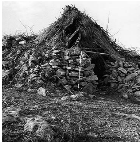
Construcciones pastoriles de Alhambra. e) Chozo-bombo de agricultor, levantado con piedras y cubierta vegetal.
