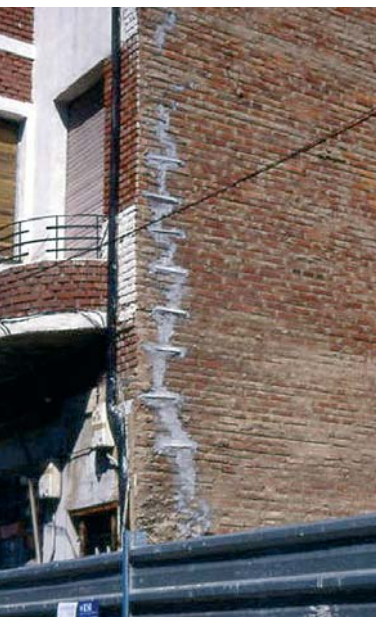
Lañas arquitectónicas en edificio en C/ Independencia, León, 2000.
