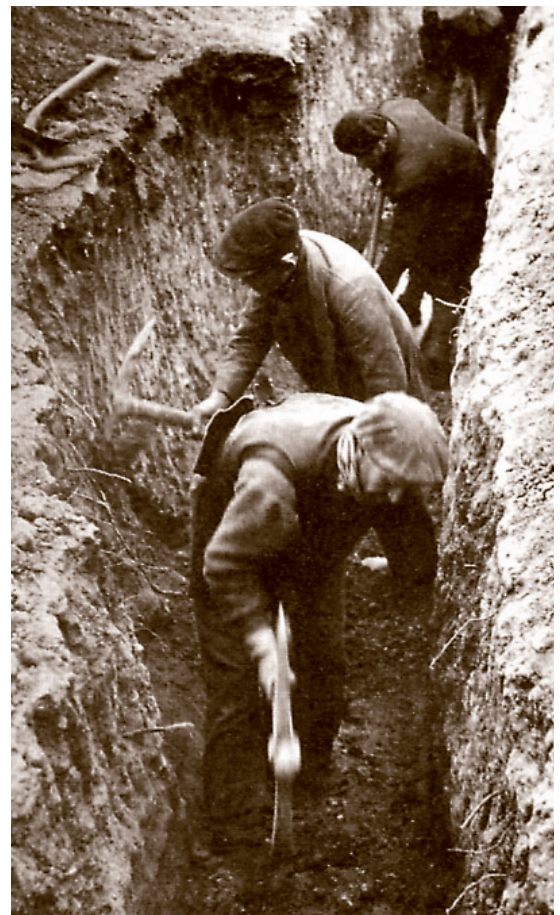
Las excavaciones sacaron a la luz una línea de trincheras de aproximadamente 80 cms. de anchura y 1,20 ms. de profundidad. En las imágenes de archivo (derecha) aparece el momento de construcción de una trinchera en el frente de Madrid y milicianos parapetados.
