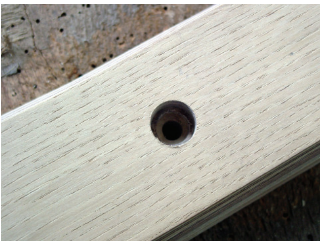
Fotos 9 y 10. Una vez presentado el travesaño se introducen tuercas de navío en el soporte original fijándolas con resina epoxi. Una vez endurecida se atornillan las fijaciones junto con las arandelas y topes de neopreno.
