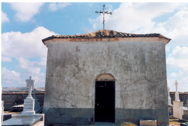
Fig. 2. Vista exterior del camarín; la puerta de acceso y el actual muro de cerramiento son obras de mediados del siglo XX, construcciones que distorsionan lo trazado por el padre Pontones en el XVIII.
