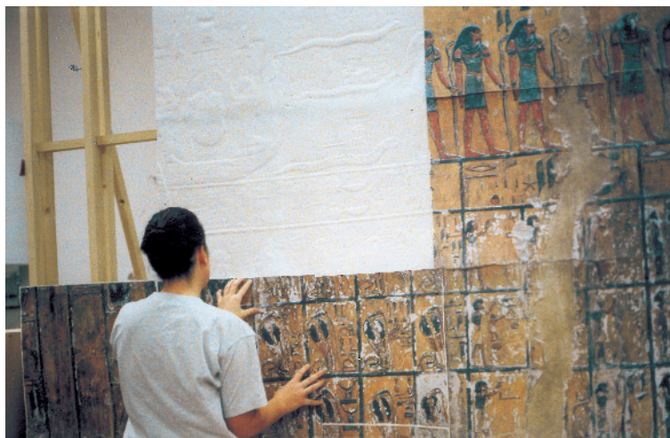
Colocación de una baldosa ya impresa sobre el muro.
