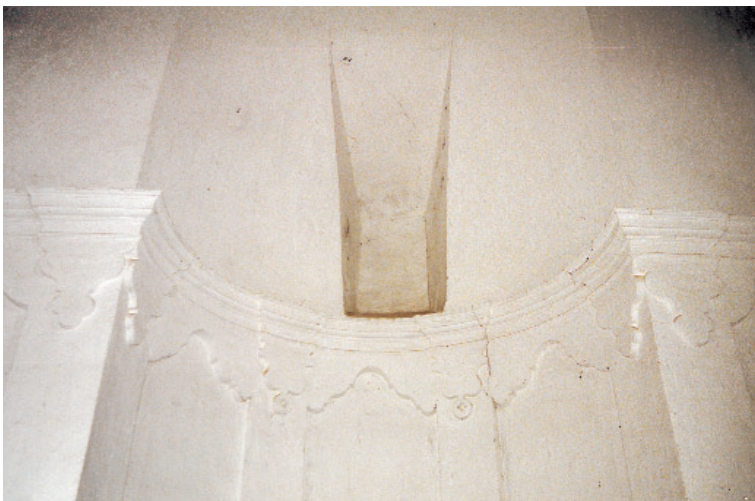
Fig. 13. PONTONES. Detalle de uno de los nichos cóncavos, decorado con paños cajeados de gusto mixtilíneo y placas recortadas que sustituyen a los capiteles.
