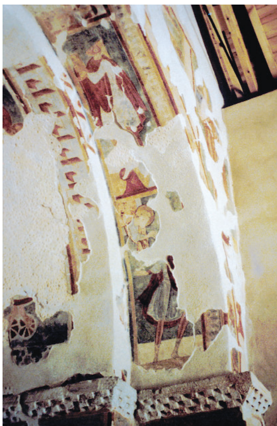
Detalle de las pinturas después de la restauración.
