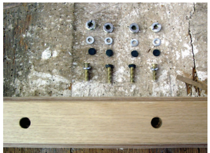
Fotos 9 y 10. Una vez presentado el travesaño se introducen tuercas de navío en el soporte original fijándolas con resina epoxi. Una vez endurecida se atornillan las fijaciones junto con las arandelas y topes de neopreno.
