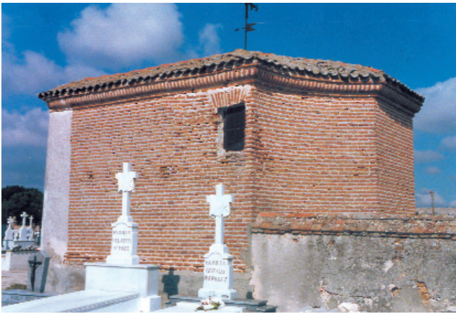
Fig. 3. Izquierda. FRAY ANTONIO DE PONTONES. Detalle de uno de los laterales del camarín; obsérvese que la obra original está realizada en ladrillo isódomo, perforándose el muro con un solo ventanal. Fig. 4. Derecha. FRAY ANTONIO DE SAN JOSÉ PONTONES. Panorámica del testero en el camarín de la Virgen de la Vega, donde se combina un rítmico juego de curvas y rectas; fíjese en el muro perimetral, perteneciente al actual cementerio de Alcazarén, barrera que ha posibilitado su conservación y al mismo tiempo el desconocimiento por parte de la crítica.
