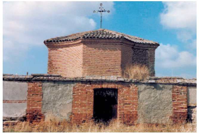
Fig. 3. Izquierda. FRAY ANTONIO DE PONTONES. Detalle de uno de los laterales del camarín; obsérvese que la obra original está realizada en ladrillo isódomo, perforándose el muro con un solo ventanal. Fig. 4. Derecha. FRAY ANTONIO DE SAN JOSÉ PONTONES. Panorámica del testero en el camarín de la Virgen de la Vega, donde se combina un rítmico juego de curvas y rectas; fíjese en el muro perimetral, perteneciente al actual cementerio de Alcazarén, barrera que ha posibilitado su conservación y al mismo tiempo el desconocimiento por parte de la crítica.
