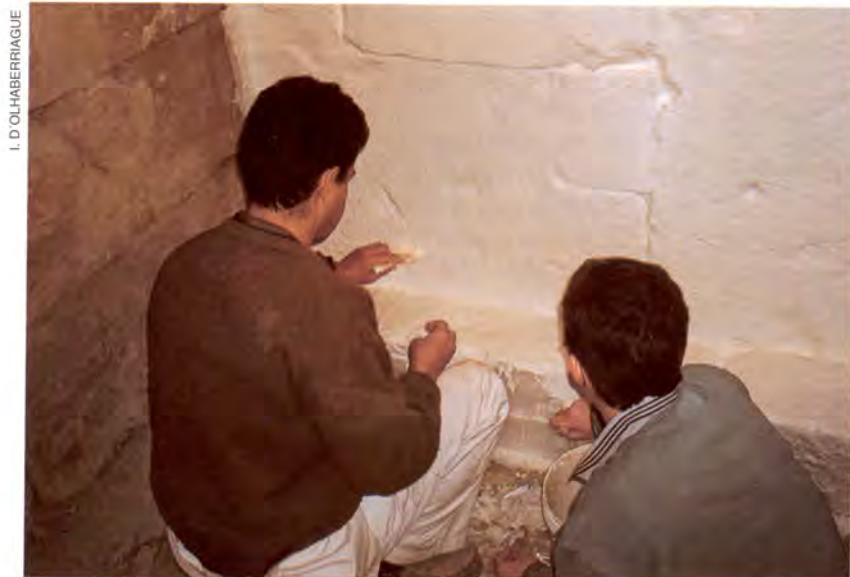
2. Realización del molde de uno de los muros con banco corrido. Aplicación del látex con velo de fibra de vidrio.
