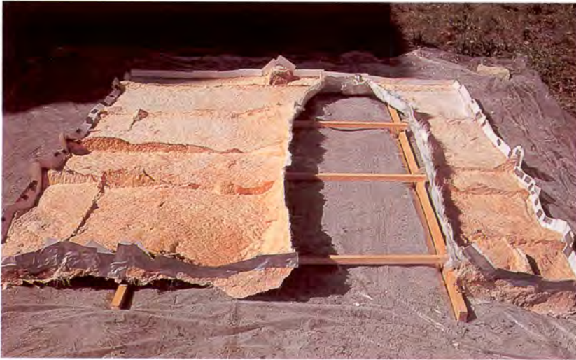
5. Molde acabado y colocado sobre su carcasa armada con listones de madera.
