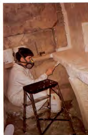
3. Realización del molde del muro con mesa adosada. Aplicación de la fibra de vidrio amorfa y del látex.
