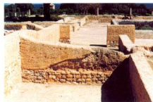
Visita a la ciudad greco-romana de Ampurias, detalle de las últimas intervenciones de reintegración de muros.
