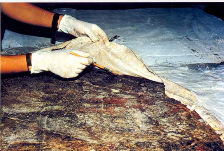
5. Retirada paulatina de las protecciones adheridas con resina acrílica empleando disolvente cetónico.
