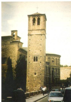
Vista general de la iglesia.
