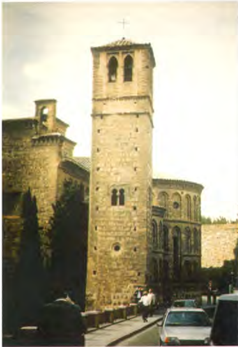
Vista general de la iglesia.
