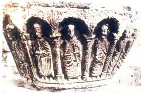
1. Estado de la obra en la década de los años 40
