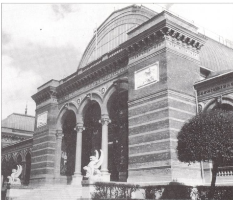
Foto 26.- Estado final. P rtico principal.
