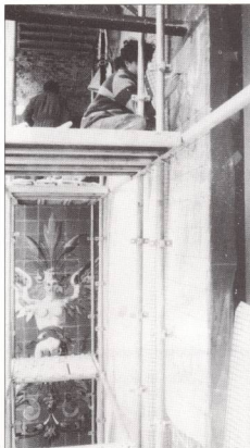
Elaboración de calco escala 1:1 en pilastra izquierda para su reproducción en la zona faltante (pilastra derecha).
