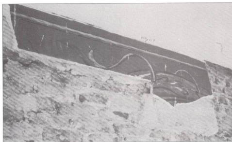
Foto 12.- Eliminación de reintegraciones de escayola pintada.
