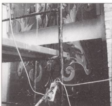
Foto 23.- Montaje de paneles sobre el muro preparado y nivelado. Elevación mediante doble polea y sujeción con eslinga. Posterior fijación a la pared con tacos Fisher SRS (100 mm).
