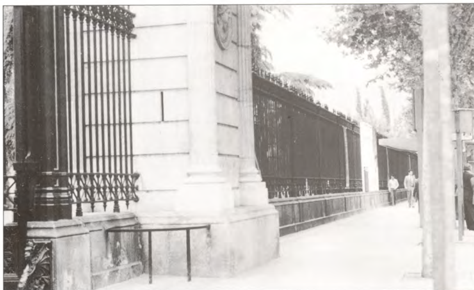
Foto 8.- Las verjas de los edificios históricos constituyen una parte del sistema perimetral de seguridad.
