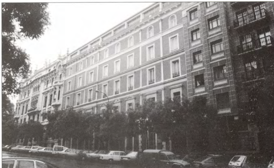
Foto 3.- La mimesis en la ampliación de un edificio. El edificio que alberga el Museo de Artes Decorativas, de Madrid, era originalmente un palacete de dos plantas.
