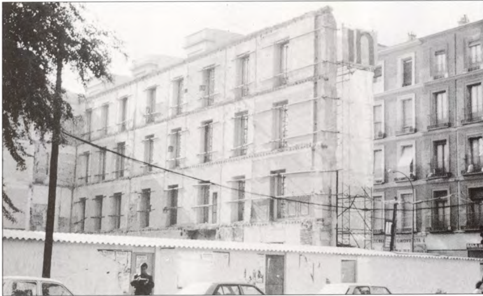
Foto 1.- Desgraciadamente se ha generalizado la eliminación de las estructuras de los edificios antiguos conservando sólo la fachada.
