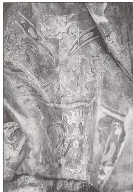
Foto 4.- Catas de limpieza en el manto de la Virgen.
