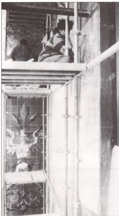
Elaboración de calco escala 1:1 en pilastra izquierda para su reproducción en la zona faltante (pilastra derecha).
