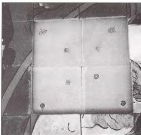
Foto 22.- Detalles de fijación al muro.
