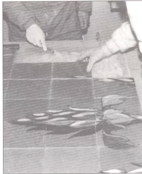
Foto 18-19-20.- Montaje de paneles, manteniendo la continuidad de aristas y piezas. Comprobación de paralajes.
