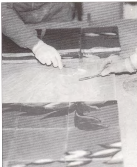
Foto 18-19-20.- Montaje de paneles, manteniendo la continuidad de aristas y piezas. Comprobación de paralajes.
