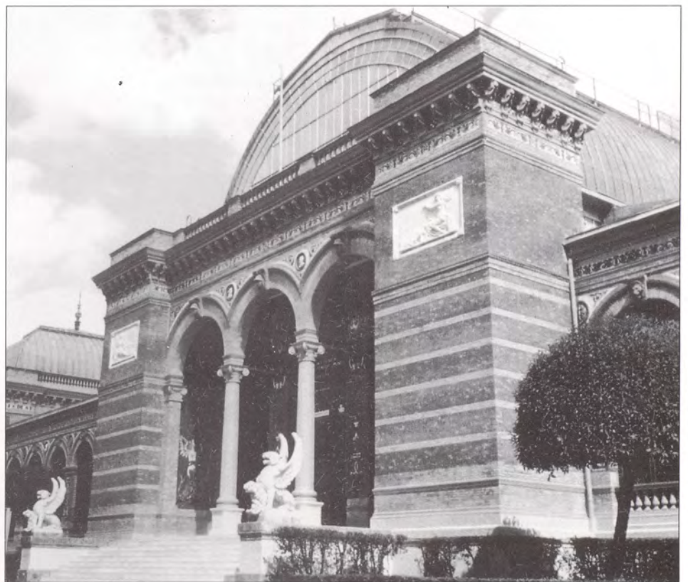
Foto 26.- Estado final. Pórtico principal.
