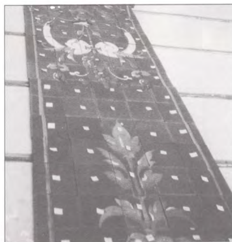
Foto 7-8-9.-Montaje provisional y siglado temporal por el anverso. (Replanteo). Ajuste y medición real de los paños y pilastras para su posterior ubicación sobre paneles autoportantes.
