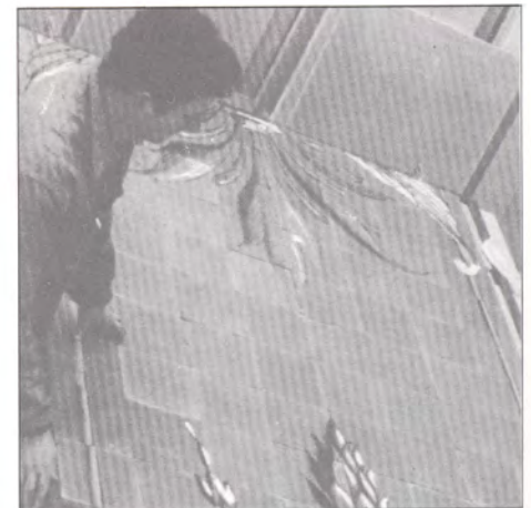
Foto 18-19-20.- Montaje de paneles, manteniendo la continuidad de aristas y piezas. Comprobación de paralajes.
