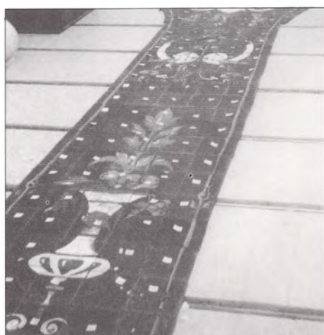
Foto 7-8-9.-Montaje provisional y siglado temporal por el anverso. (Replanteo). Ajuste y medición real de los paños y pilastras para su posterior ubicación sobre paneles autoportantes.
