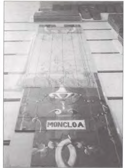
Foto 14.- Montaje. Preparación y despiece de paneles AEROLAM F-BOARD (Ciba-Geigy). La dimensión de cada panel se establece en función del peso y la facilidad de manejo y transporte. (Ver plano de montaje).
