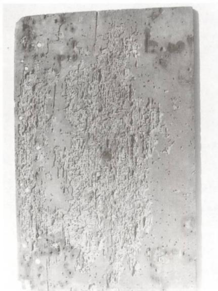
Galerías producidas por la carcoma en la madera de la cubierta.
