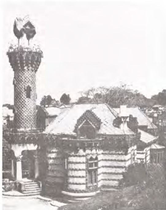
Foto 3. "El Capricho". Vista de la crujía occidental y la torre-mirador.
