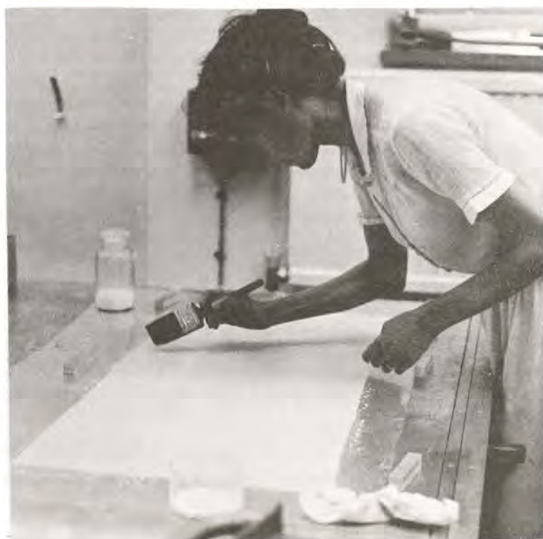
1. Impregnación de gasa de nylon con Mowilith.
