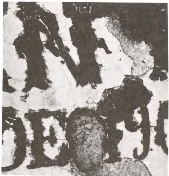
Nº 2. Pérdida del vidriado.
