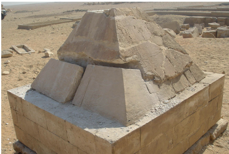
Imagen 5. Inicio del desmontaje de los bloques de la reintegración de caliza.
